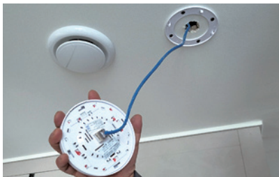
〈인출구가 보이지 않도록 무선공유기(단말장치)를 설치하는 경우 예시〉
